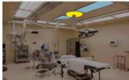
Il sistema AC a barriera d'aria è progettato con due diffusori d'aria filtrata sopra il tavolo separato dai dispositivi di illuminazione e scialitica, oltre ad un sistema perimetrale di diffusori a feritoia ad alta velocità progettato per tenere distante la contaminazione ambientale dalla zona critica del campo operatorio.
